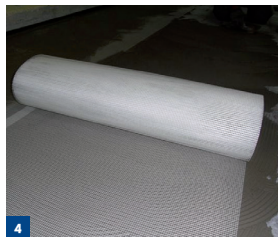
4 Préparer et dérouler la TRAME LANKOPHONIC sur le lit du mortier-colle.
