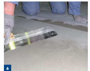
6 Marouflage de la TRAME LANKOPHONIC avec un couteau à lisser, excepté avec 554 PROLIFLUIDE RAPIDE en locaux P2 uniquement.
