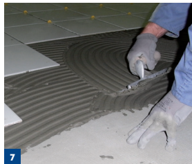
7 Application du mortier-colle.
