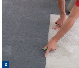
2 Pose des plaques, la face marquée vers le sol.
